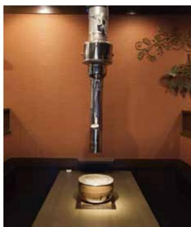
■ フードの先端を片手で簡単に上下に動かす事ができるワンショットフードを採用。ライトも付いていて焼き加減がクリアに分かるのもポイント
