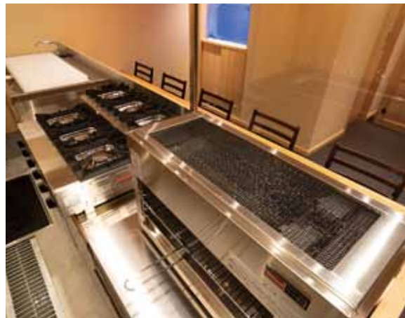
■厨房 遠赤外線でじっくり火を通すグリルに六連のコンロが据えられている
